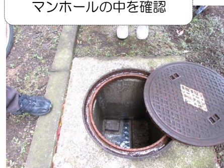
排水管に色水を・・・ マンホールの中を確認
